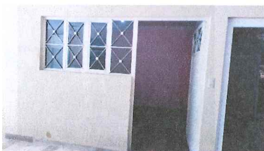
Acceso a la bodega electoral
