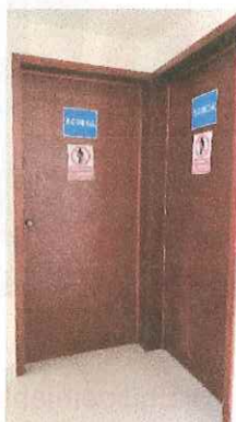
Acceso a la bodega electoral
