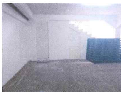
Acceso a la bodega electoral
